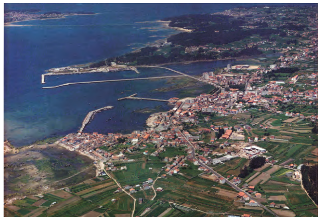
Vista aérea de Cambados onde se aprecian as obras no peirao de Tragove
